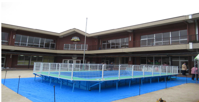
新しいプールが、設置されました！（6月7日）
