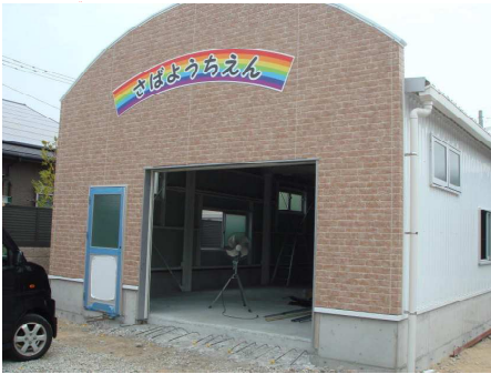
完成した新教具倉庫(8/17)
